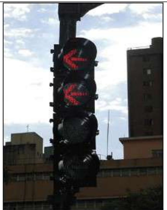
Foto 07 – Grupo focal veicular a led 4 focos de 200 mm (4x200mm) Máscara de seta.
